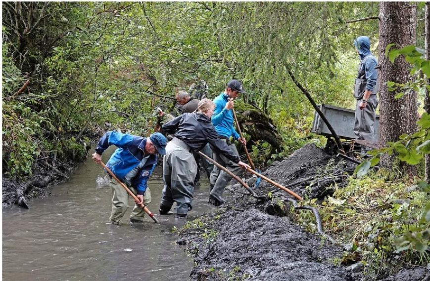
Zur Revitalisierung des Channenbachs wurde viel Sediment aus dem Gewässer entfernt und mit Flusskies ersetzt. Foto: Heidy Mumenthaler
